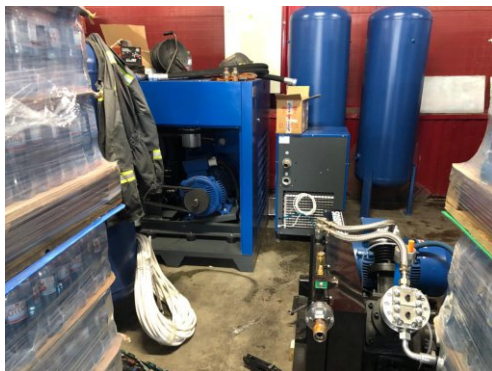
«Форштадтская пивоварня», монтаж пневмолинии для выдува ПЭТ
