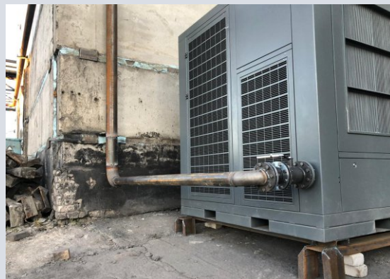
ООО «Голухинский цемент», монтаж и пусконаладка
