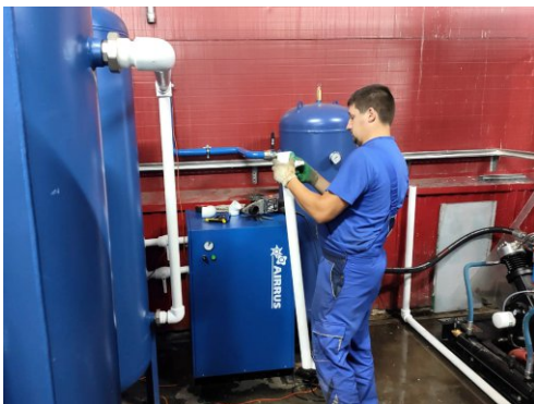
«Форштадтская пивоварня», монтаж пневмолинии для выдува ПЭТ
