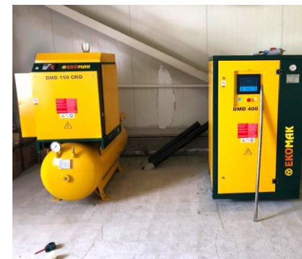
пескоструйные работы ООО «Айкхофф-Сибирь»
